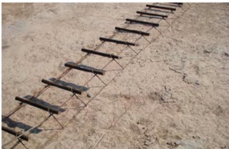
Colocación con Canastos Imagen de referencia.
