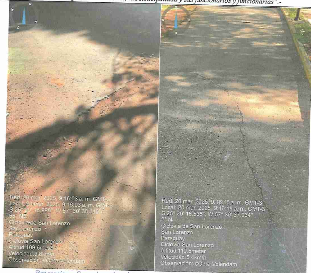
Reparaciones Generales sobre el circuito. Fisuras en la carpeta asfáltica.
