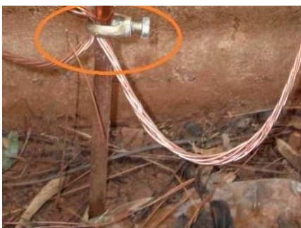
Conector de la jabalina con el conductor
