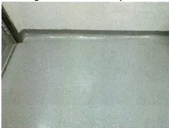
Piso con pintura epoxi y zócalo con curvatura
