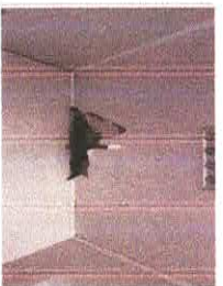
Mantenimiento y pintura de Cieloraso en el Salón Municipal
