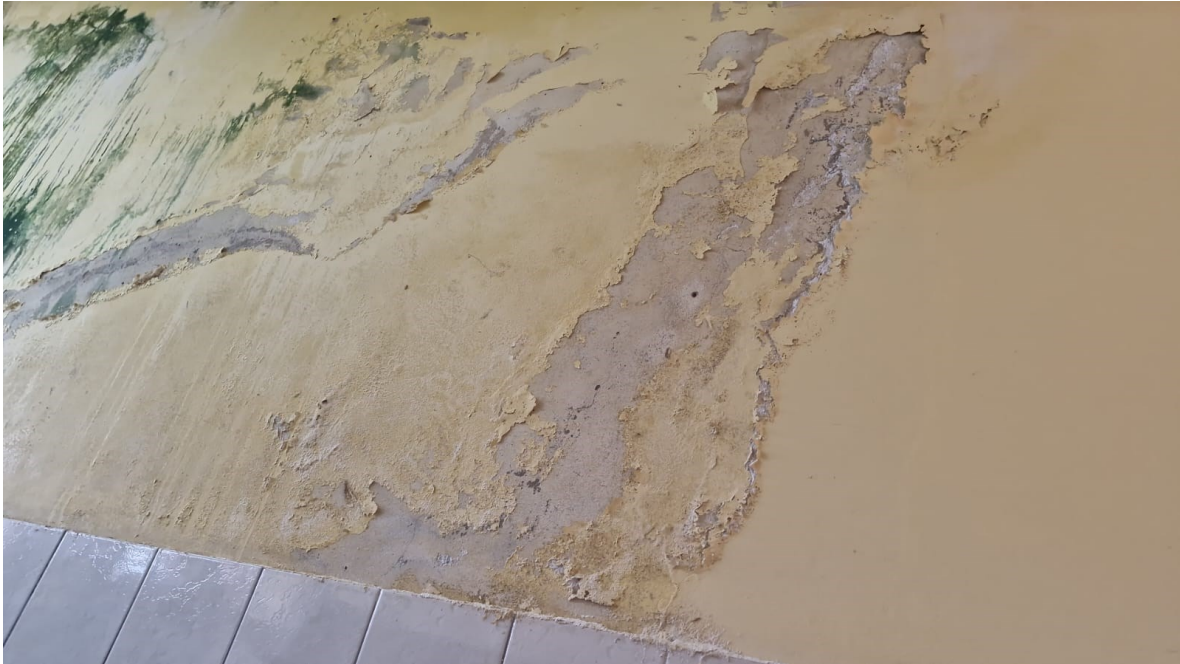
Lote 1: sanitario imagen
