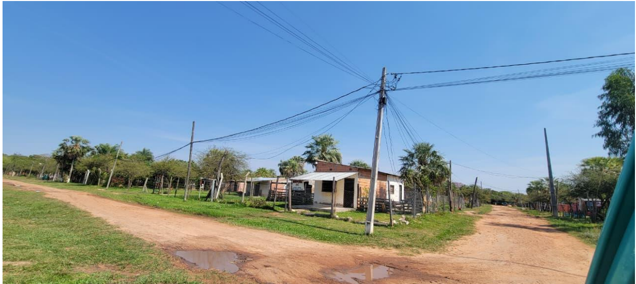
Figura 10: Vista de red de baja con cables pre-ensamblados y postes para futura expansión.
