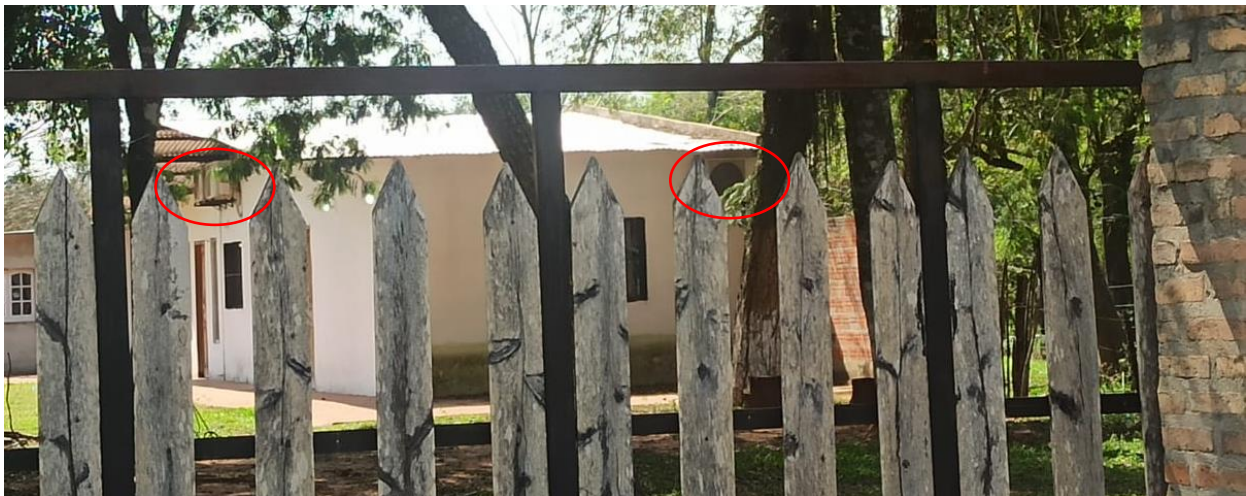
Figura 11: Imagen de vivienda con tres aparatos acondicionadores de aire.
