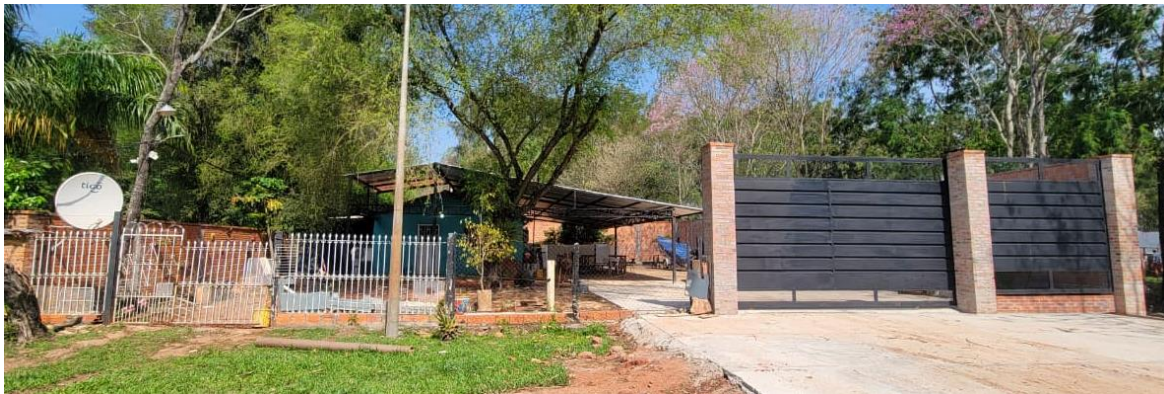
Figura 8: Vivienda dónde ingresa directamente la red de baja tensión.
