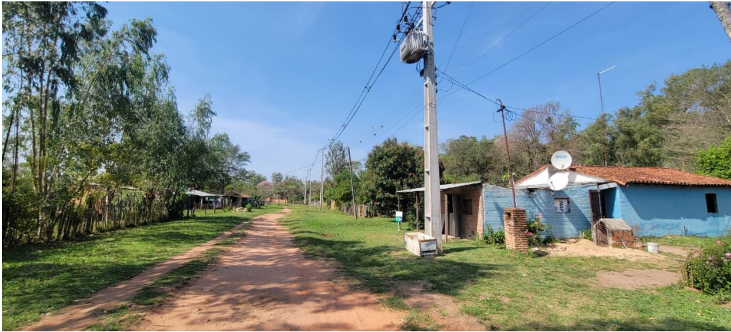
Figura 7: Puesto de distribución con red MT protegida, vivienda con múltiples servicios de TV.
