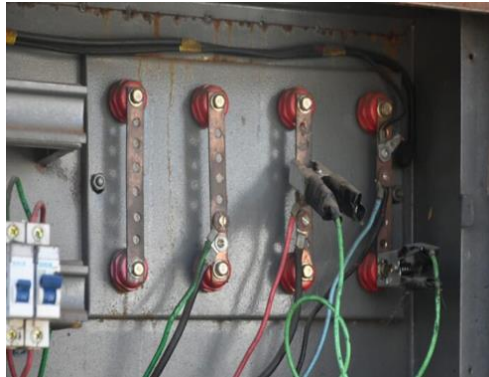
Figura 1: Ejemplo de conexión clandestina.
