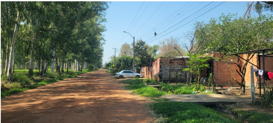
Figura 9: Avenida principal, vista de las redes de media y baja y servicio de alumbrado público.
